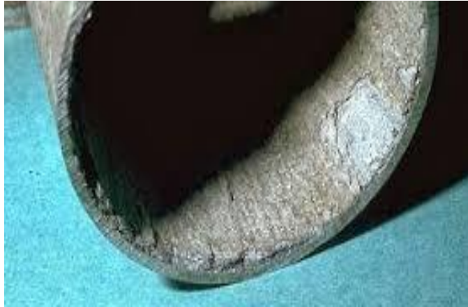
Gambar 2. 7 Korosi batas butir pada pipa
