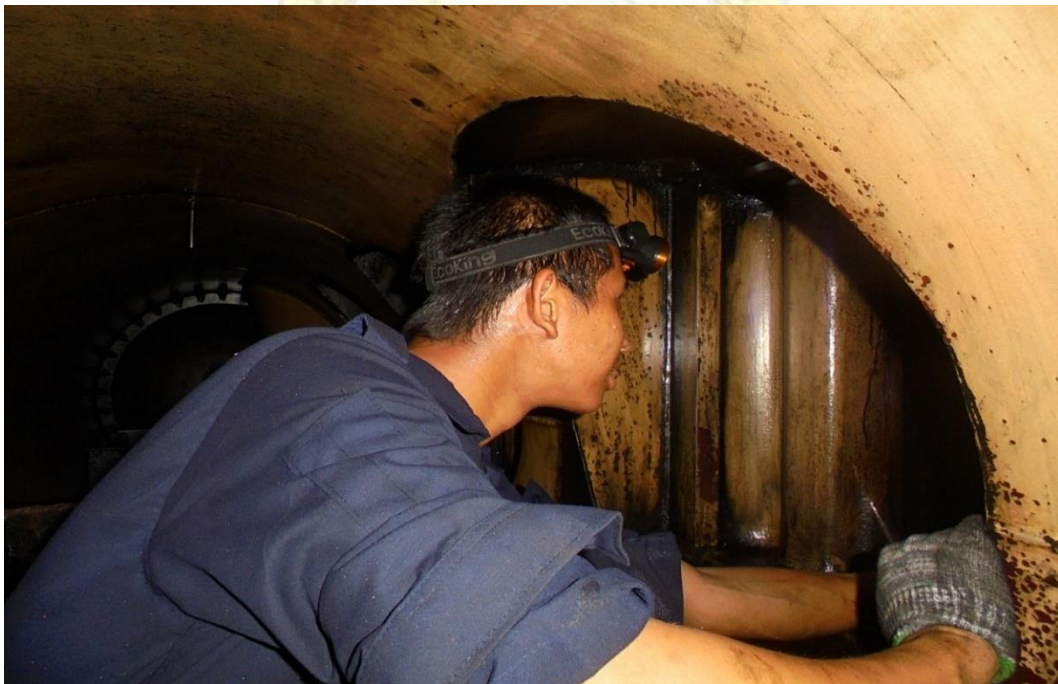
Gambar: Pembersihan Jelaga atau Kotoran Pada ruang udara bilas
