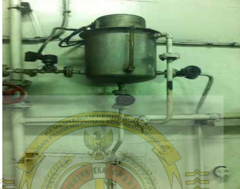
Gambar: Tangki air tawar untuk pengeblowan purifier.
