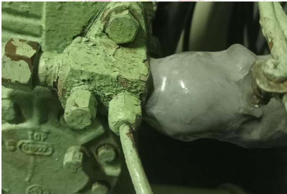
Melakukan perbaikan kebocoran pipa hisap compressor MT. RATU RUWAIDAH
