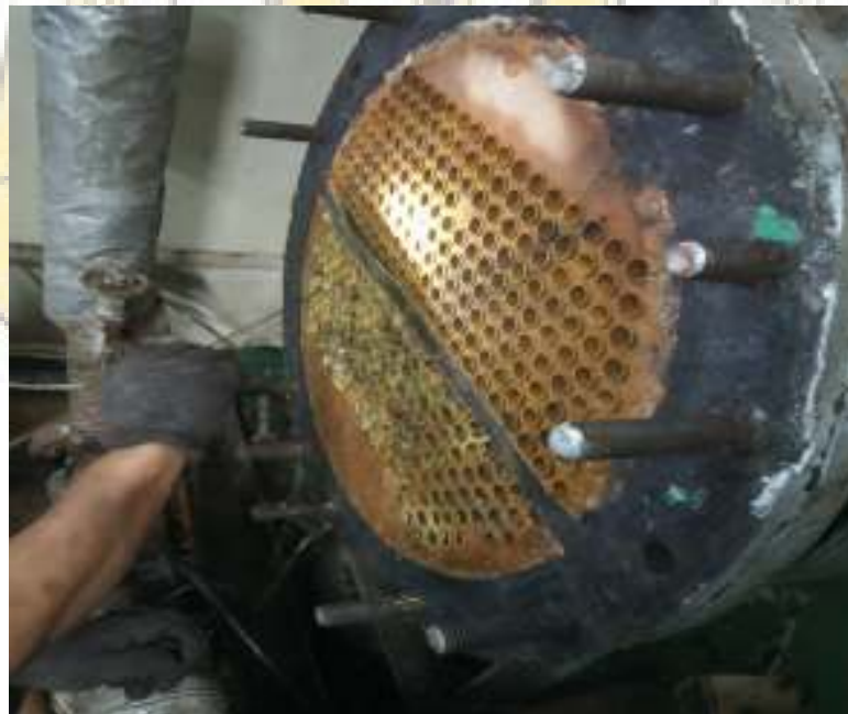
Membersihkan sumbatan pada tube atmospheric condenser
