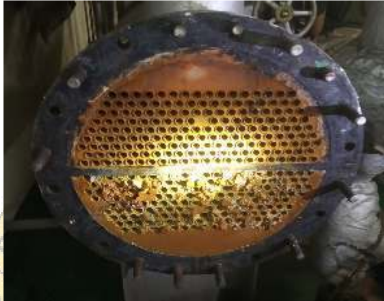
Tube pada atmospheric condenser tersumbat oleh sampah dari laut
