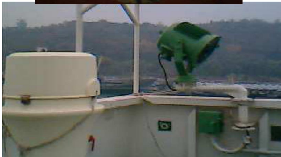
Gyro repeater yang berada di wing bridge yang harus disinkronkan dengan master gyro
