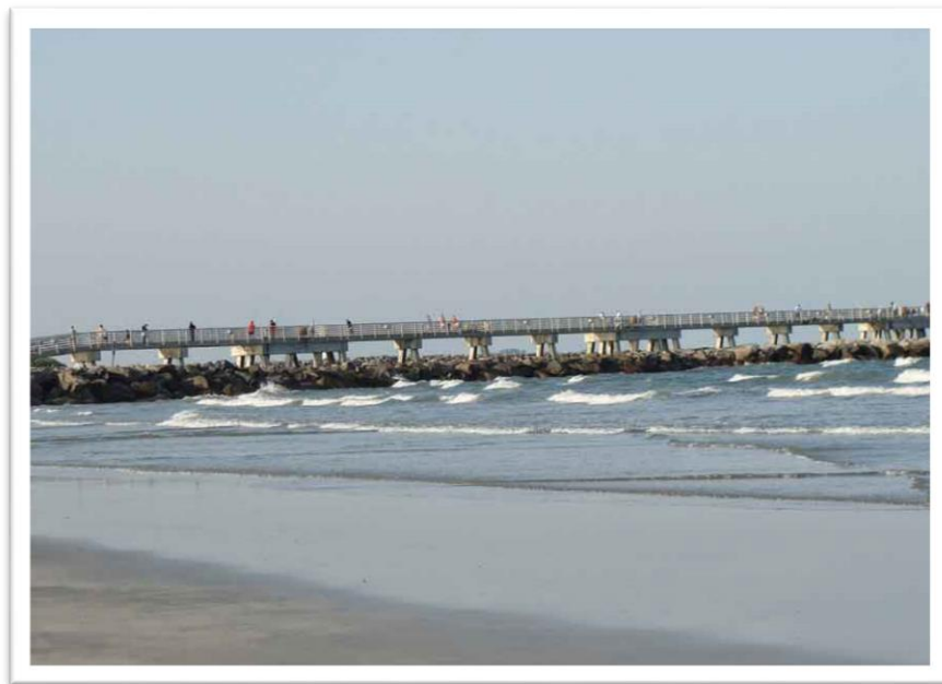
Gambar 2.1. Jetty dermaga (Sumber: Solusi kontruksi)
