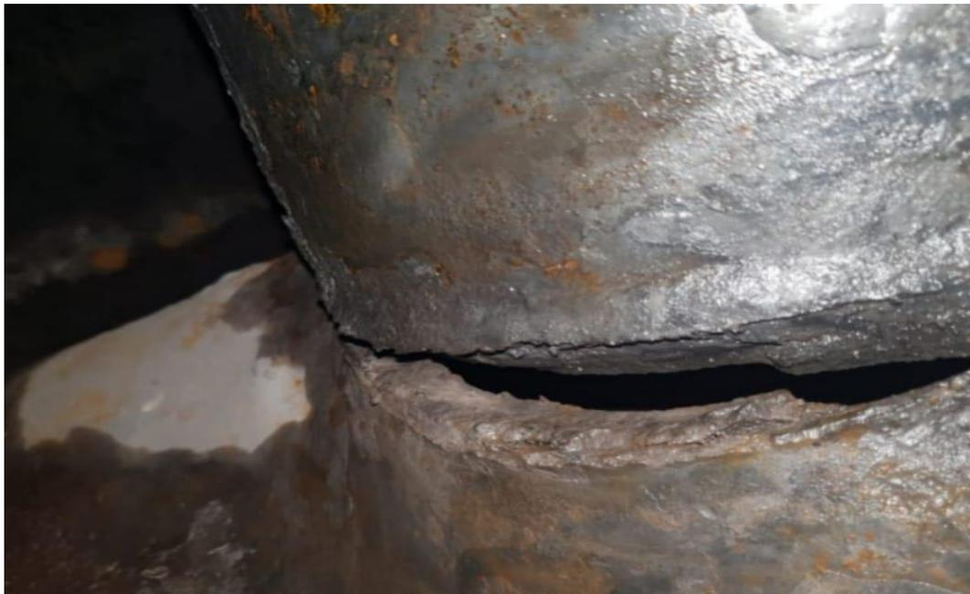
**Gambar Retakan pada dinding *Furnace***
