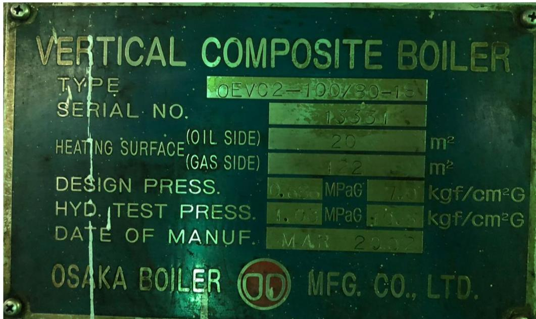
**Gambar Spesifikasi Auxiliary Boiler**
