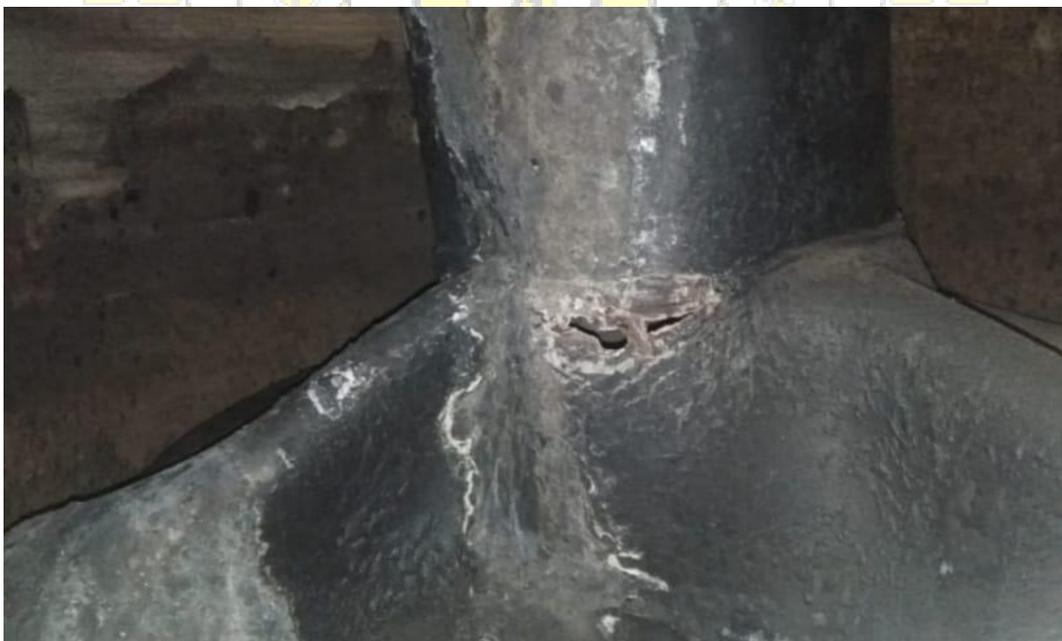
**Gambar Pemuaiian pada dinding *Furnace***
