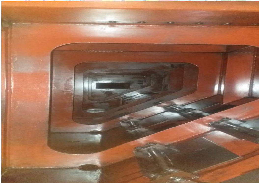
Scavenge air room setelah dibersihkan
