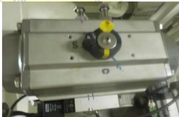
Gambar 2.3 *Actuator (piston actuator)*
