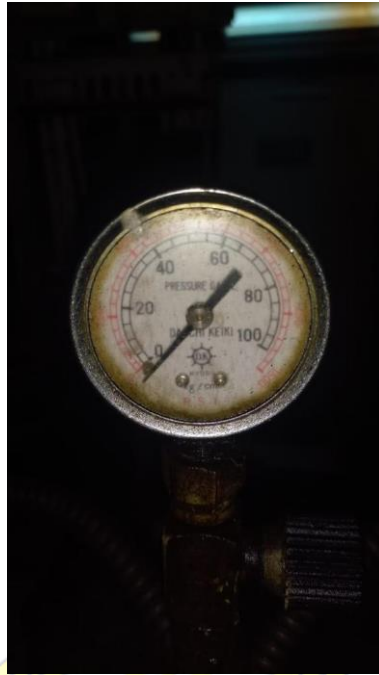
Pressure gauge pompa hidrolik
