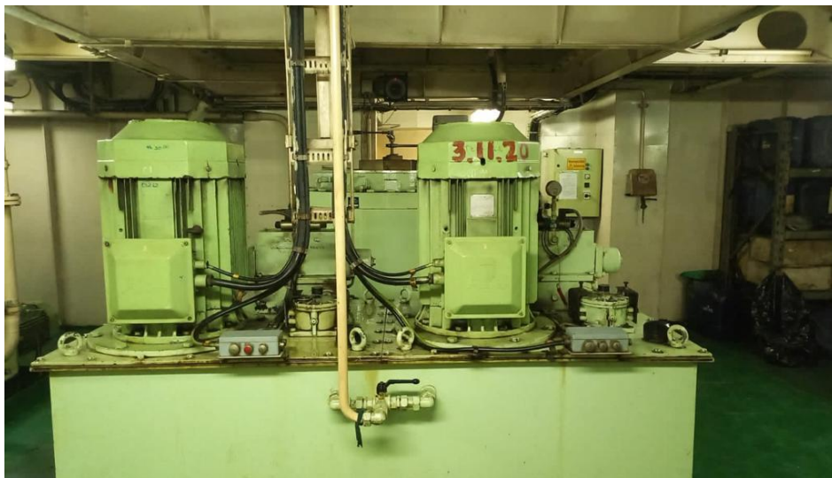
Pompa hidrolik steering gear
