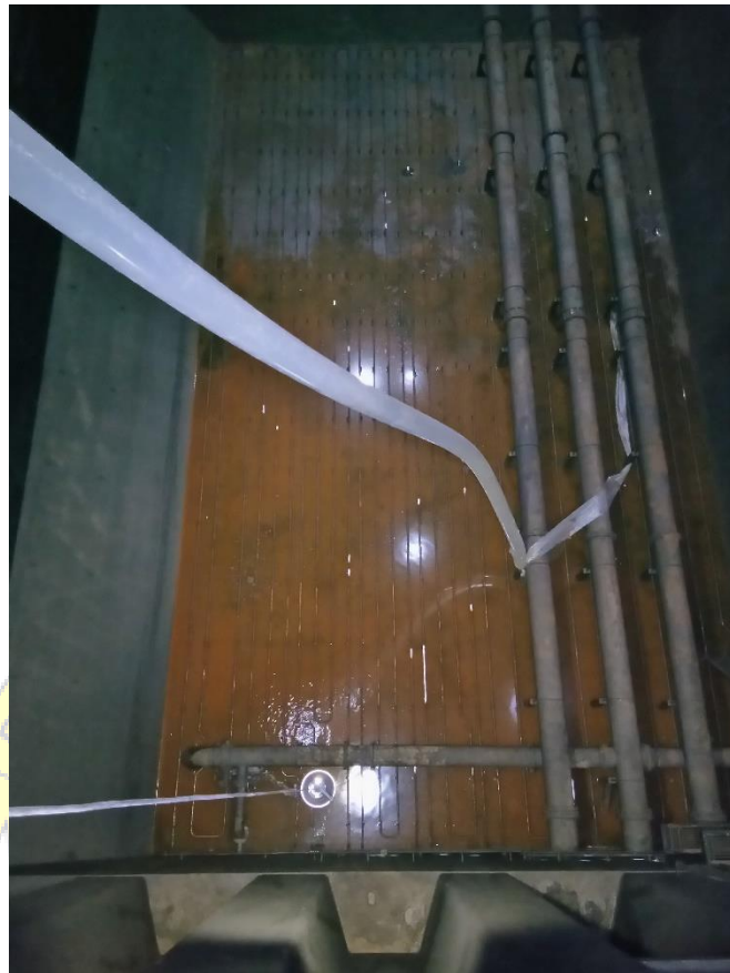
Memasukkan udara segar menggunakan portable blower
