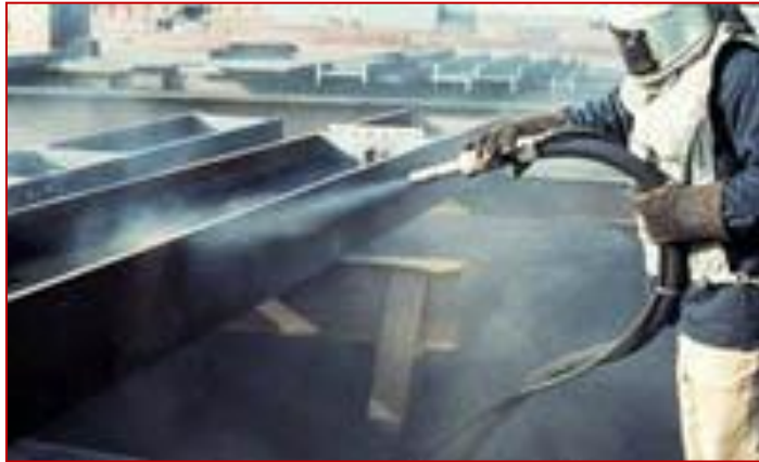
Gambar 4.6. Pelindung pernafasan saat sand blasting .
