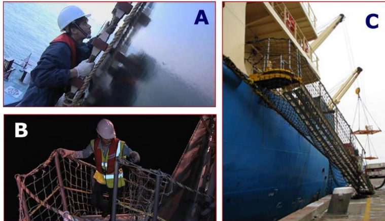
Gambar 4.12. Pemasangan tali jaring pengaman.
