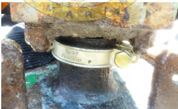
Setelah dilaksanakannya maintenance
