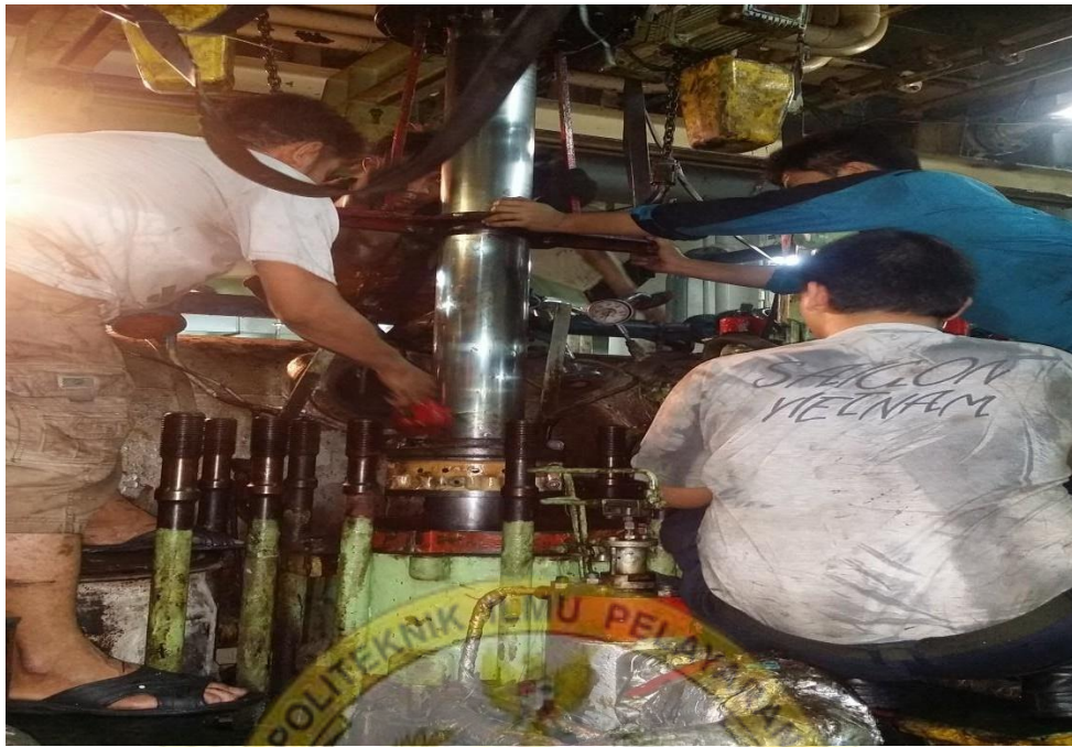
Lampiran 1.5 Bekerja tidak safety
