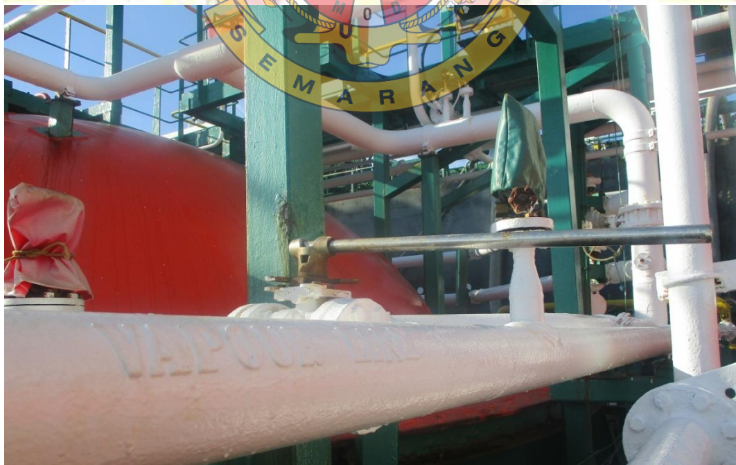
Gambar 10.4. Stung di manifold untuk menyempotkan vapour ke liquid line
