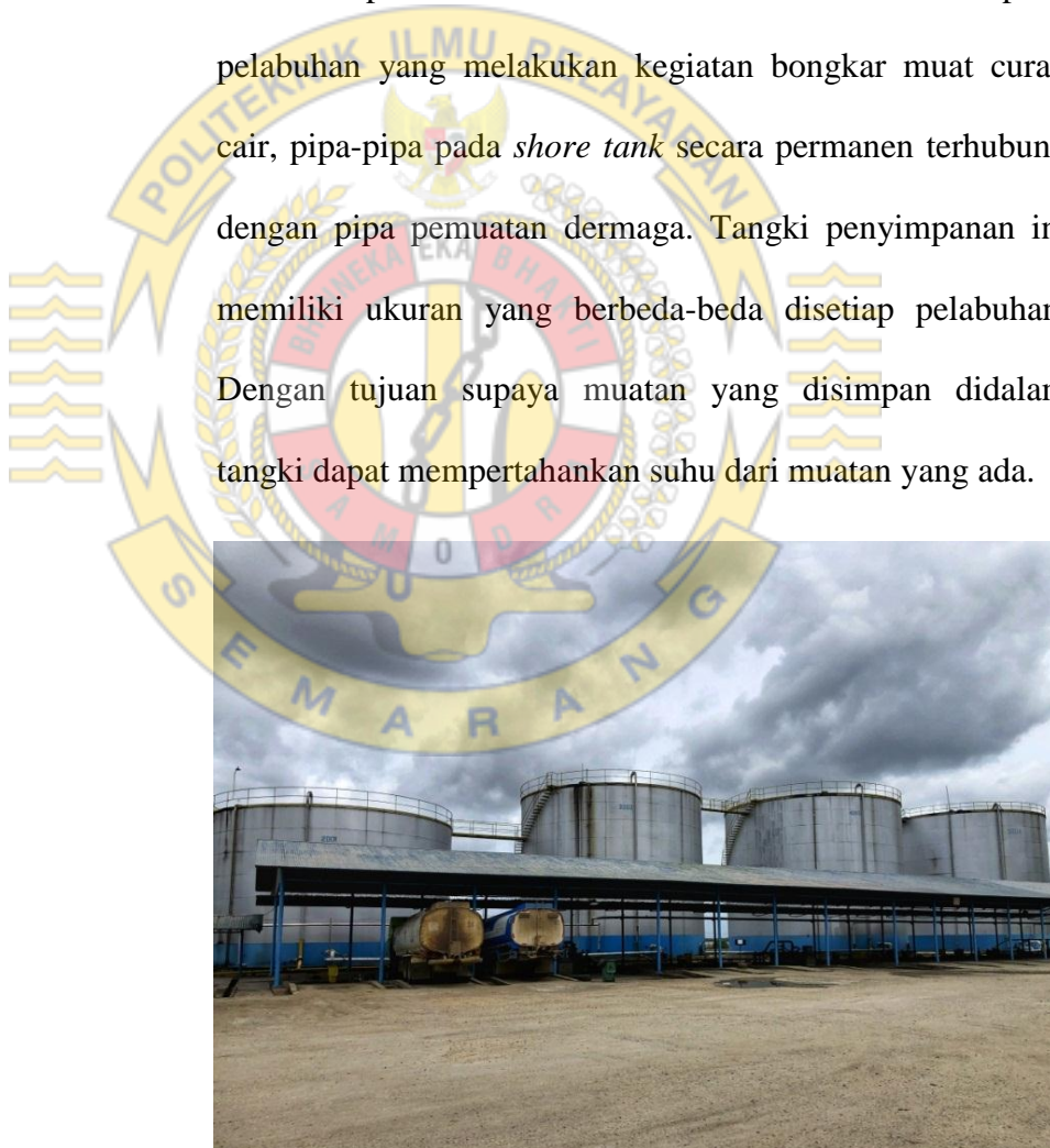
Gambar 2. 1 Shore Tank Teluk Bagus
