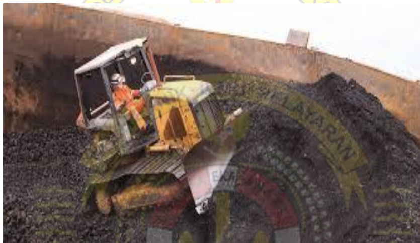
Cooling Down dengan dozer Sumber : Dokumen pribadi
