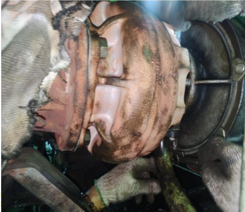
Gambar: pemasangan turbocharger A/E no 2
