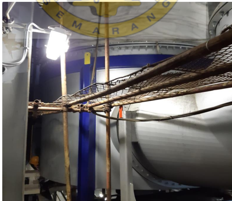
Pemasangan/proses instalasi drum absorber dan jet section
