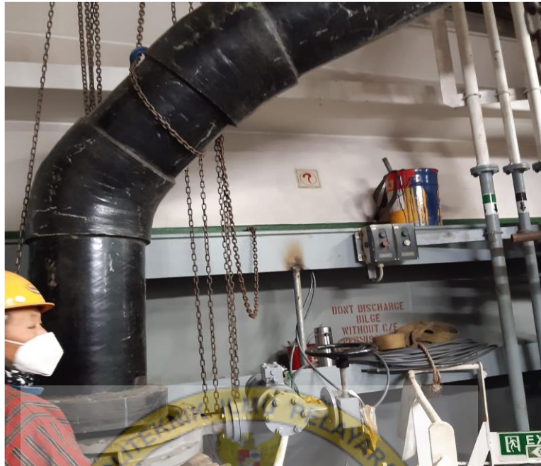
Pemasangan pipa berbahan dasar khusus pada saluran overboard / GRP ( Glass Reinforced-termosetting Plastics )
