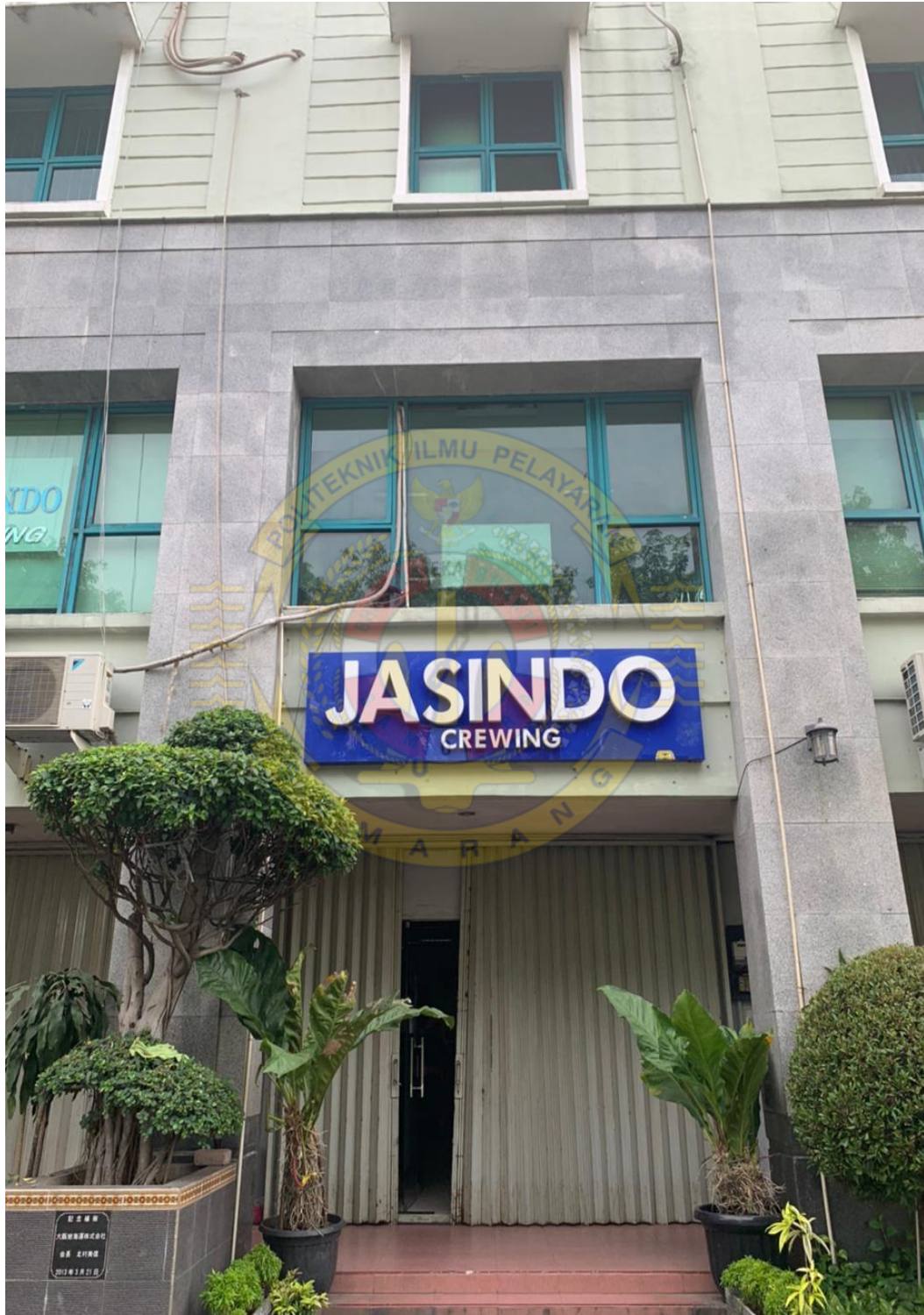
Tampilan depan gedung perusahaan PT. Jasindo Duta Segara
