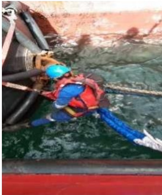
Proses Pemasangan fender yang putus
