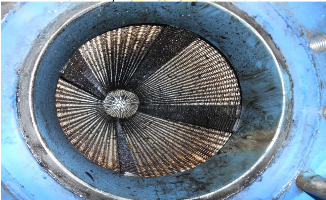
Plate lo cooler setelah dilakukan sirkulasi
