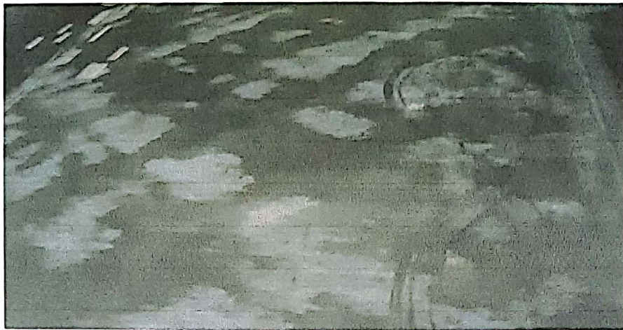
Kondisi tangki MT. Fatmawati saat gagal Cleaning
