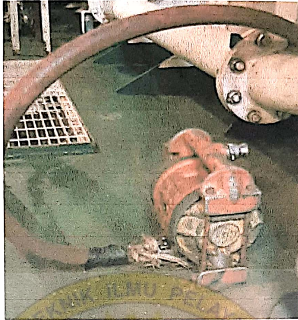
Wilden Pump MT. Fatmawati Dalam Kondisi Kurang Baik
