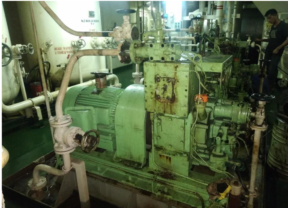
Gambar : Kondisi Kompresor Udara
