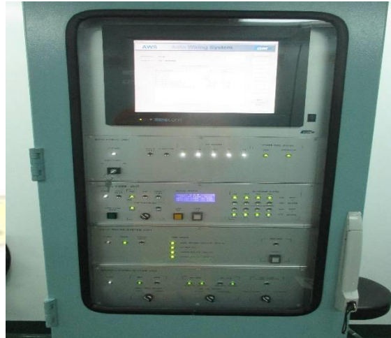
Gambar 2.10. Salah satu cabinet yang ada di B deck Tangguh Towuti
