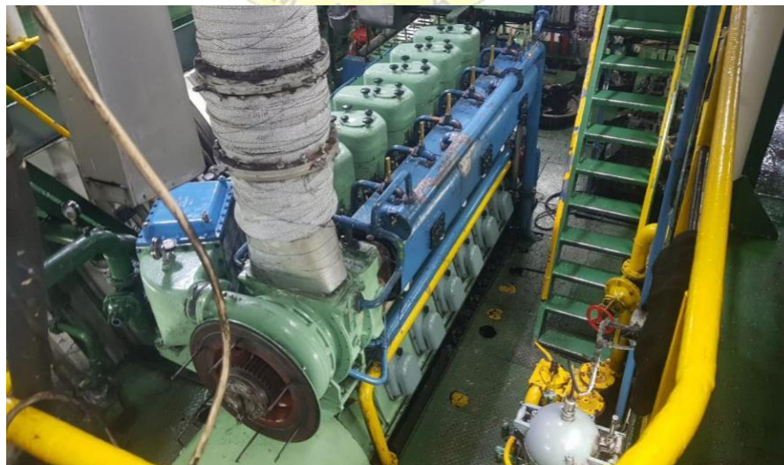
Gambar 4.16. Ruang kamar mesin telah dibersihkan
