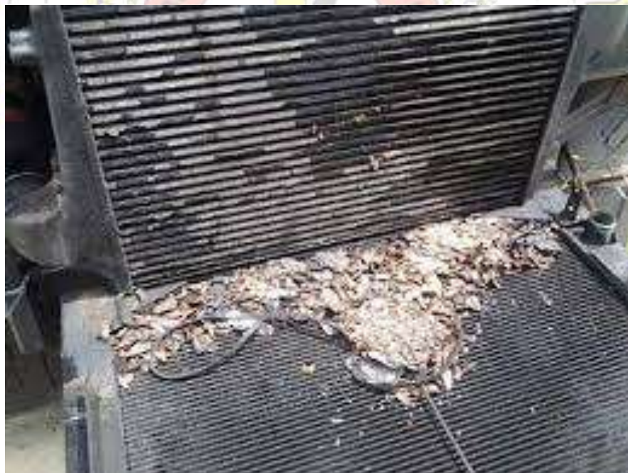
Pembersihan komponen oil cooler pada cargo crane
