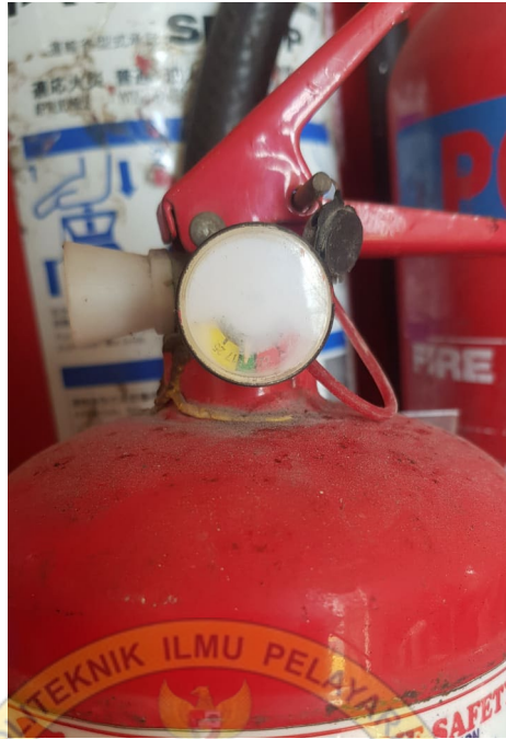
Sumber: Dokumentasi (2019) Gambar manometer yang sudah rusak
