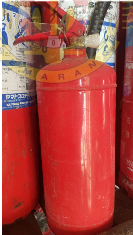
Sumber: Dokumentasi (2018) Gambar portable extinguisher yang tidak ada label
