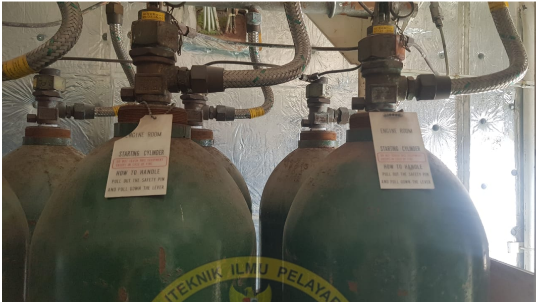
Sumber: Dokumentasi (2018) Gambar kondisi tabung CO 2 yang bocor pada saat inspeksi
