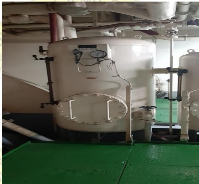
Sumber : Dokumentasi MV. Tanto Nusantara Gambar 2.1 hydrophore tank
