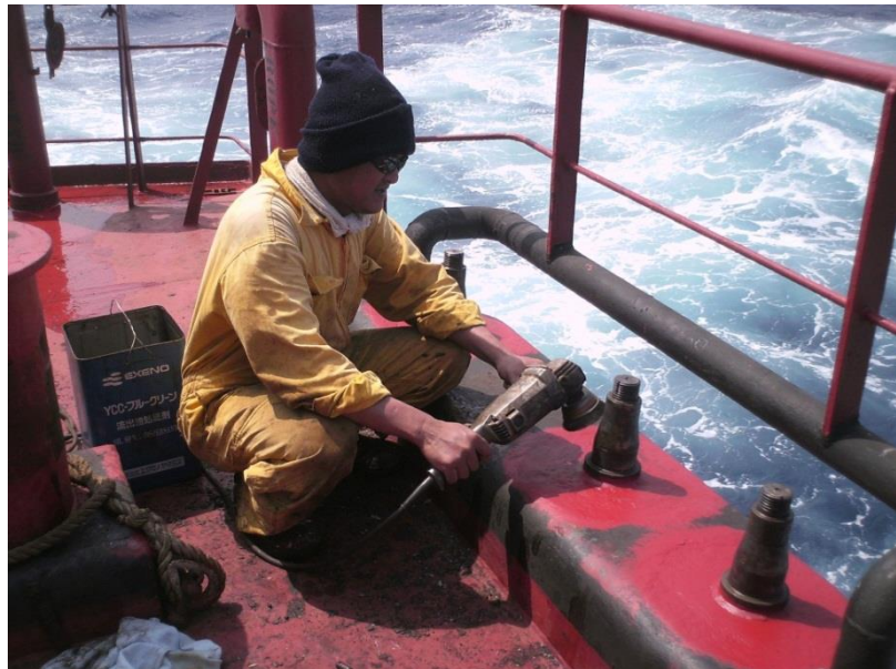
Gambar 2. Tidak menggunakan pelindung tangan dan pelindung kepala
