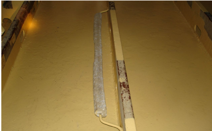
Gambar: Pengecetan Pada Lantai Tangki Ballast
