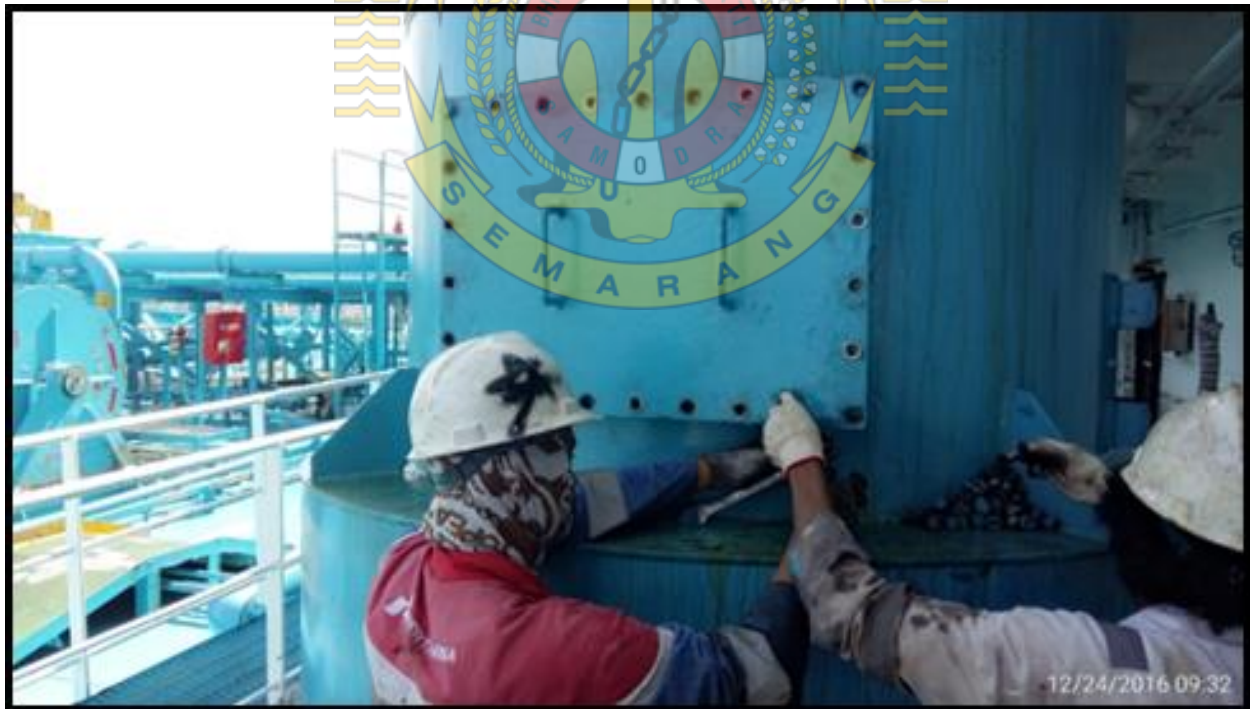
Lampiran 6.2 Gambar proses perawatan pada Deck Water Seal
