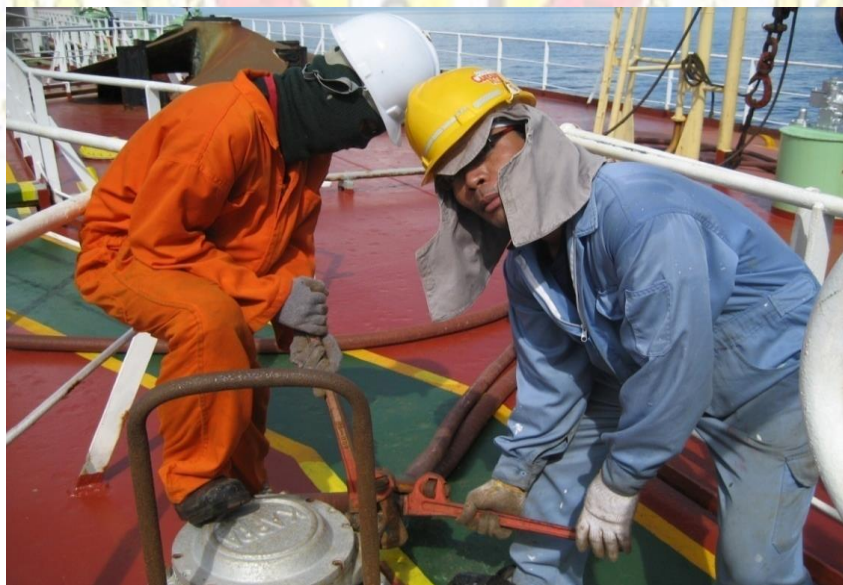
GAMBAR 2. Awak kapal sedang memasang Blower
