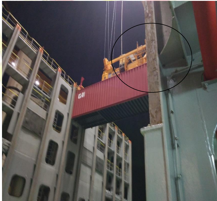
Proses bongkar muatan menggunakan gantry darat
