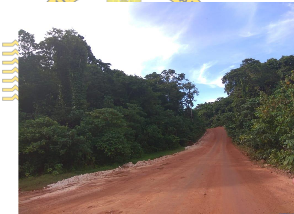
Gambar 2.2 Jalanan di area tambang
