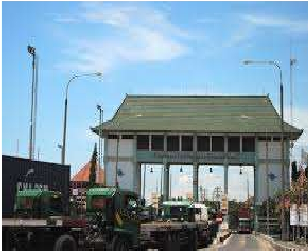
Gambar Pintu Masuk Petikemas sebelum pengembang menjadi auto gate system
