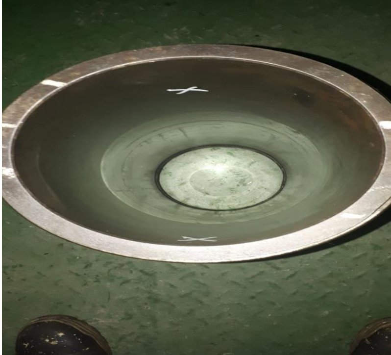
Gambar 4.10 cylinder liner yang sudah aus
