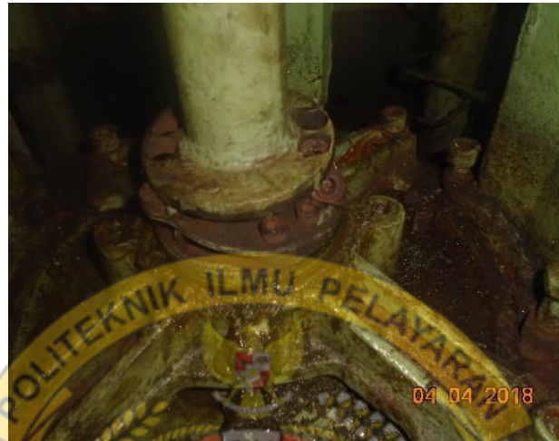
Gambar Kerusakan Disk Coupling Pompa Ejector
