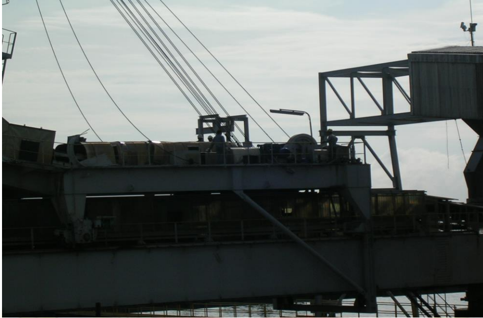
Gambar Conveyor darat untuk pemuatan pupuk urea curah ke kapal
