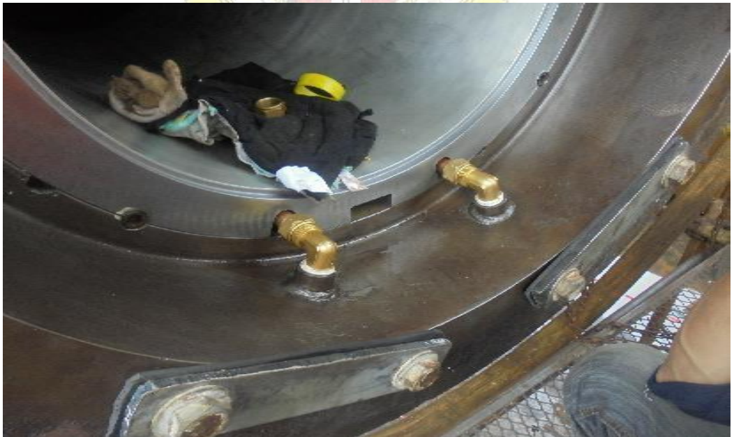
Gambar 10 Pemasangan stern tube lo pipe
