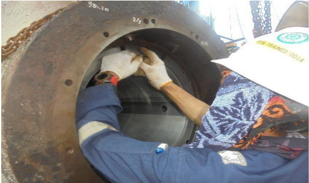
Gambar 9 Proses pemasangan stern tube yang sudah di repair
