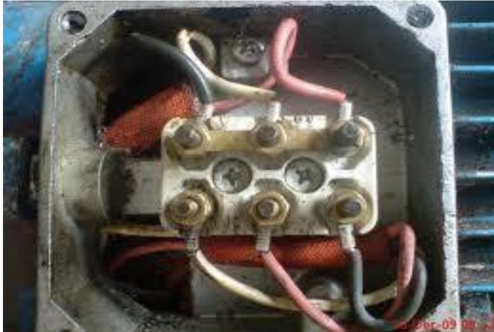
Pemasangan fase arus yang kendur
