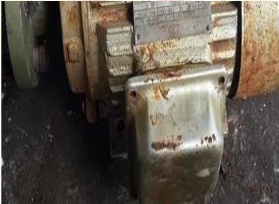
Junction box yang sudah usia
