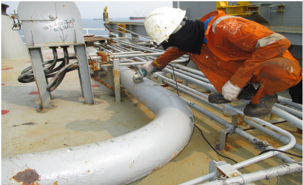
Gambar 2. Proses brushing pada pipa hidrolis.
