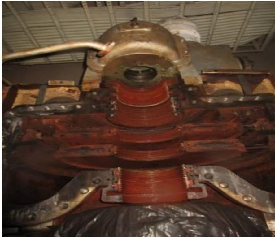
Gambar kondisi labyrinth seal
