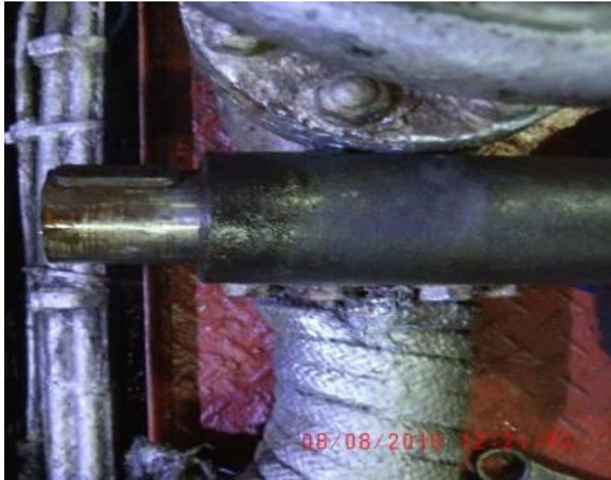
Gambar pin pengunci pada shaft turbine
