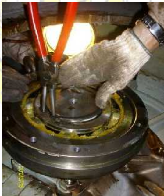
Gambar membongkar main bearing cargo pump Sumber Data: Dokumentasi Kapal MT. SC OCEAN LI
