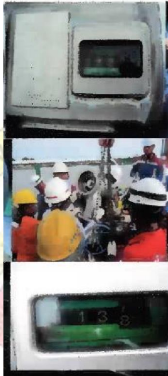
Gambar 5.14 Kerusakan pada level gauge ( floating gauge tersangkut)
