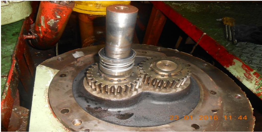
Gambar Overhoul Main LO Pump Sumber Data: Dokumentasi Kapal MT.Sinar Jogya
