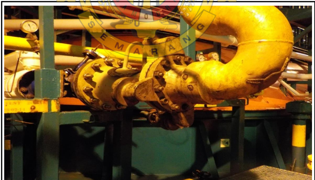
Pemasangan loading arm pada manifold LPG/C Gas Arar
