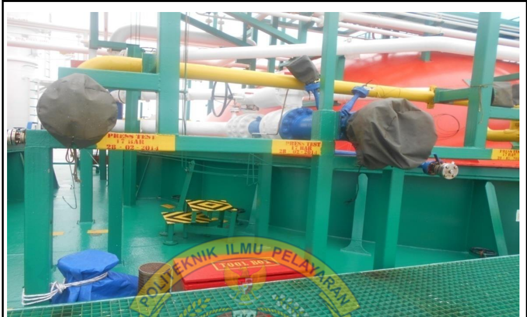
Manifold liquid dan Vapour serta Toll Box
