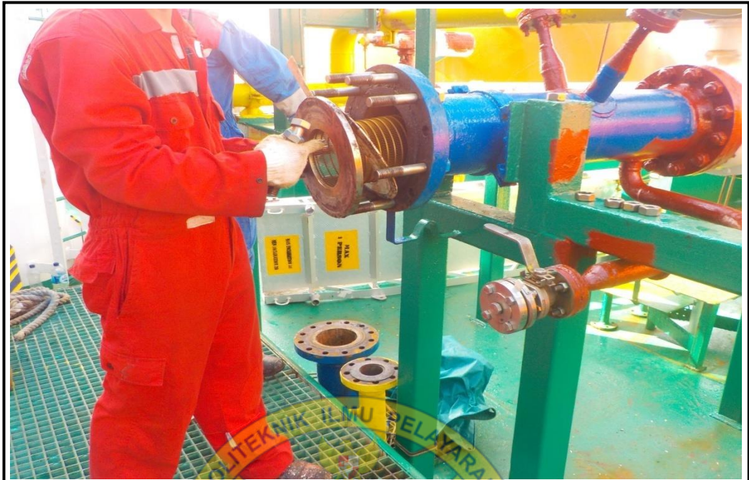
Pemasangan packing pada manifold
