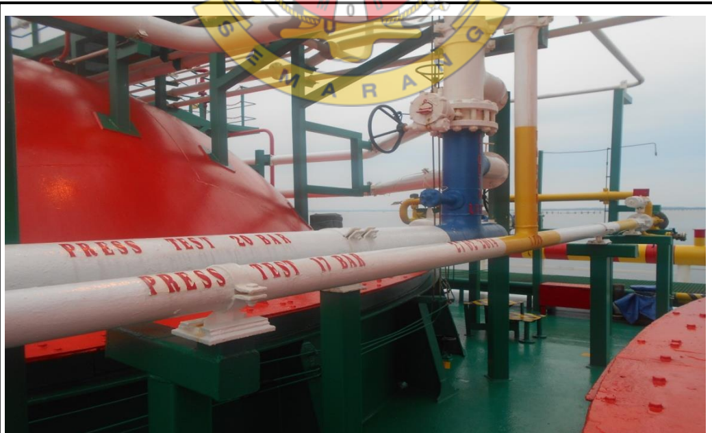
Cross over penghubung pipe line Dome 1 dan Dome 2
