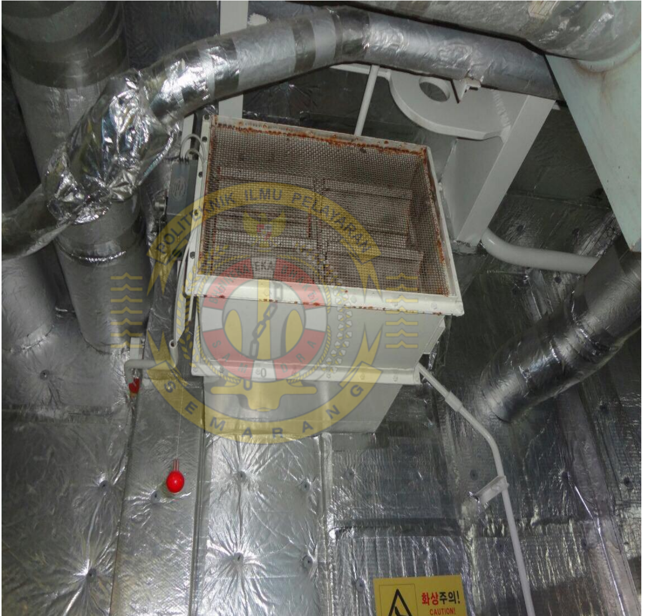
Gambar damper udara
