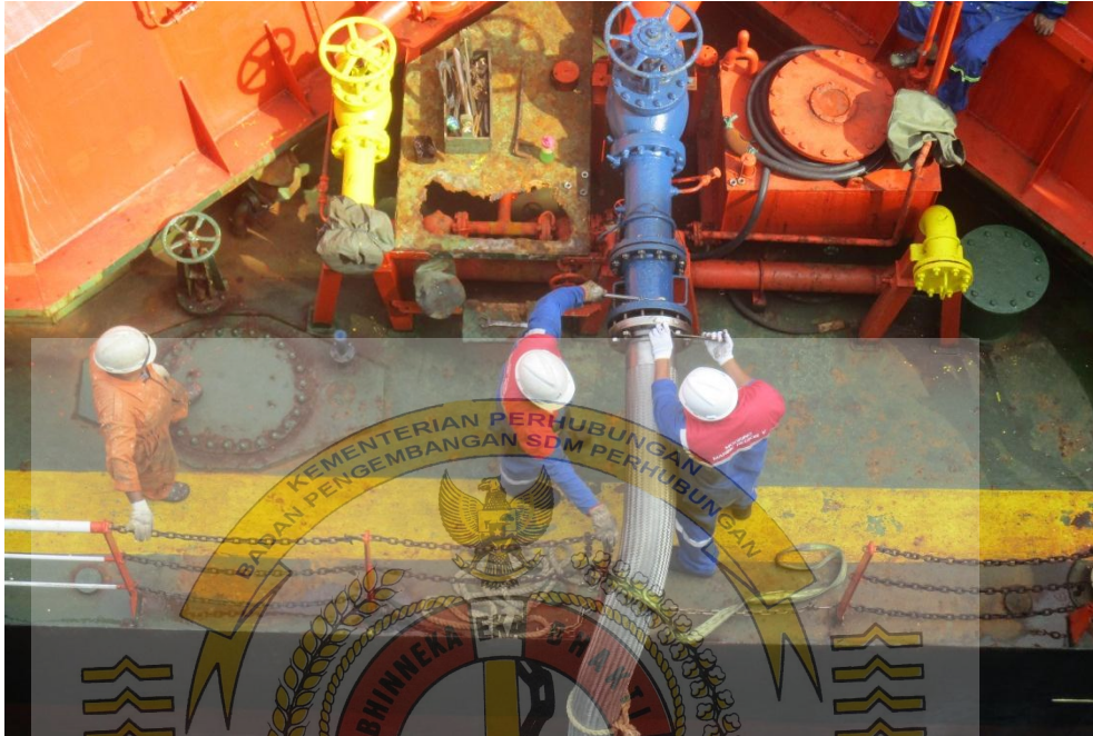
Gambar 7.1 Pemasangan cargo hose
